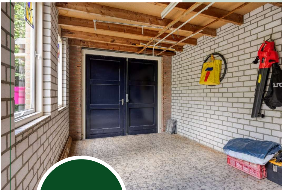
Vrijstaande stenen garage
