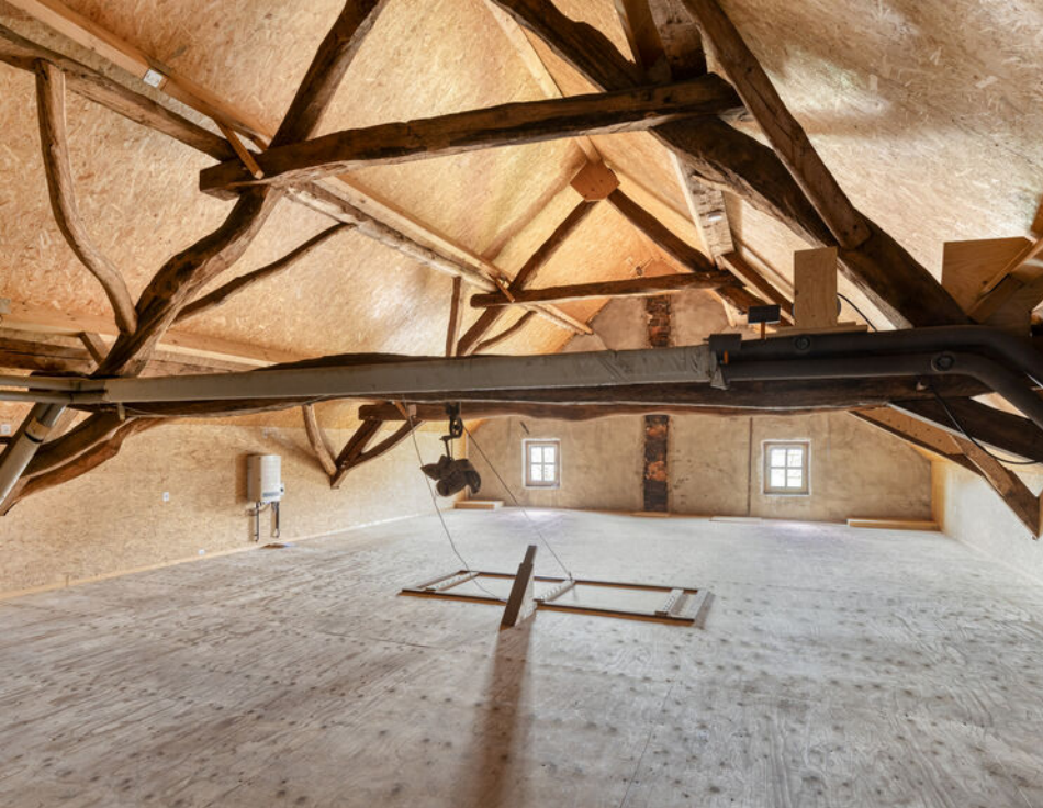
foto boven: bergzolder aan voorzijde woning
