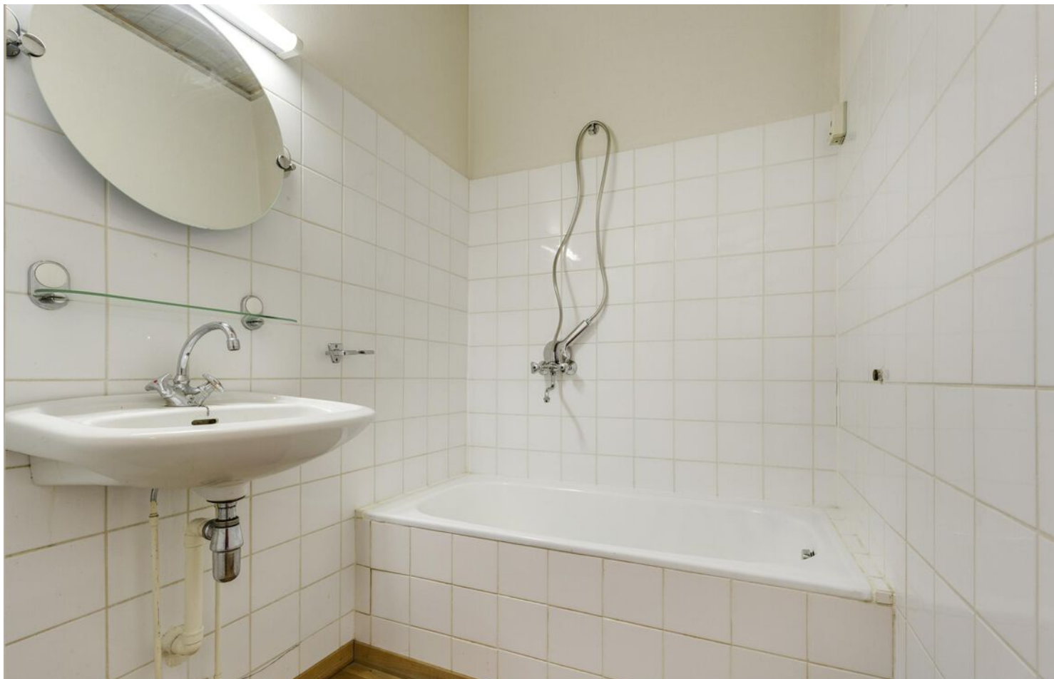
Badkamer eerste verdieping
