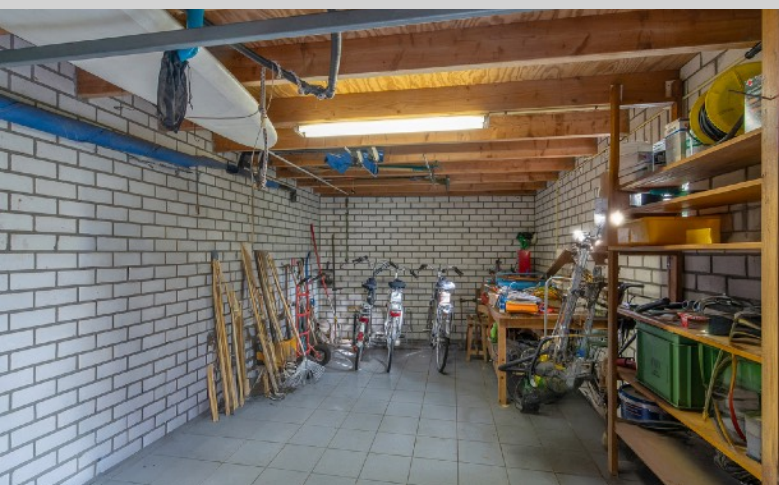
De garage heeft een tegelvloer en is voorzien van elektra.
