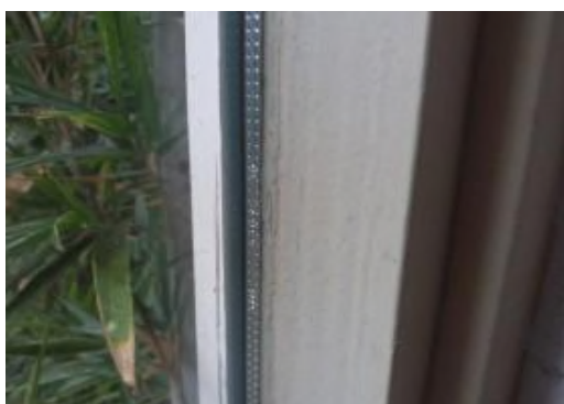
Overzichtfoto 10, houten kozijnen voorzien van dubbele beglazing.
