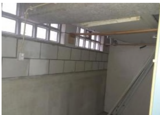
Overzichtfoto 12, berging, geen asbestverdachte toepassingen aangetroffen.
