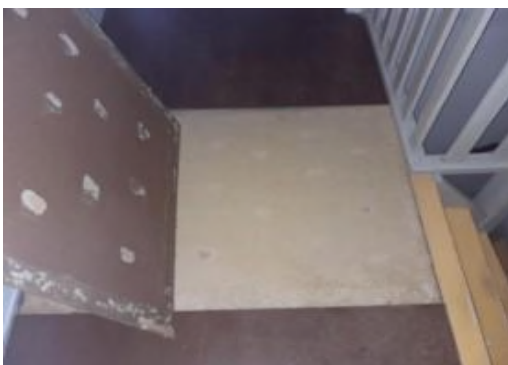
Overzichtfoto 6, vaste vloerafwerking niet asbestverdacht.
