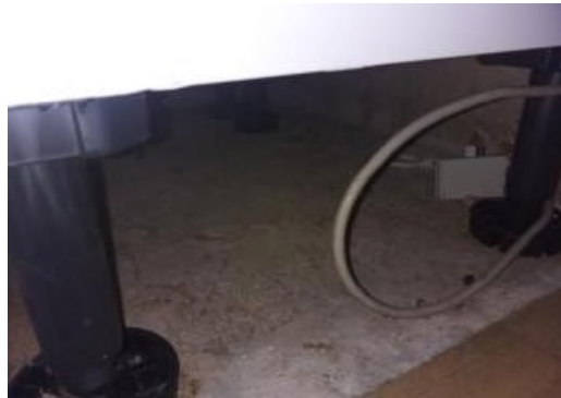
Overzichtfoto 3, onder keukenblok
