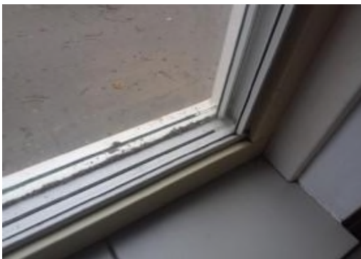
Overzichtfoto 4, schuiframen niet asbestverdacht.
