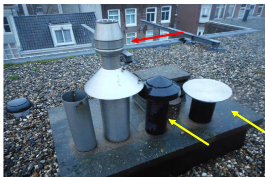
Aanzicht vanaf strang 1 (foto links). Op de foto rechts strang 1 met daarin de enige collectieve afvoerleiding in het complex. Tevens twee kruiskappen aangetroffen (gele pijlen), dit zullen voormalige ventilatie- en verbrandingsluchttoevoerleidingen van de opstellingsruimte (zie ook foto 13 in Bijlage VI).
