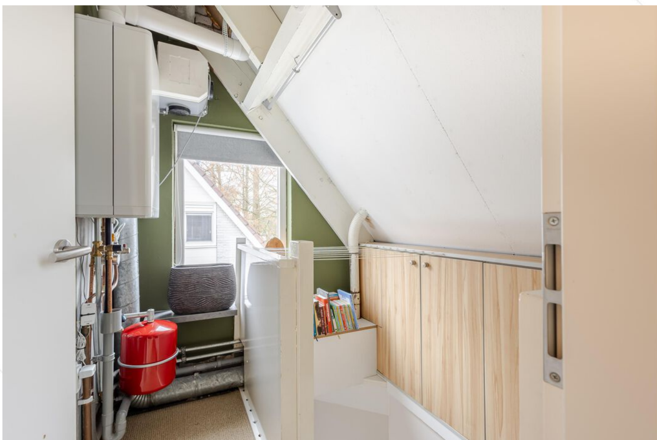
Overloop 2e verdieping
