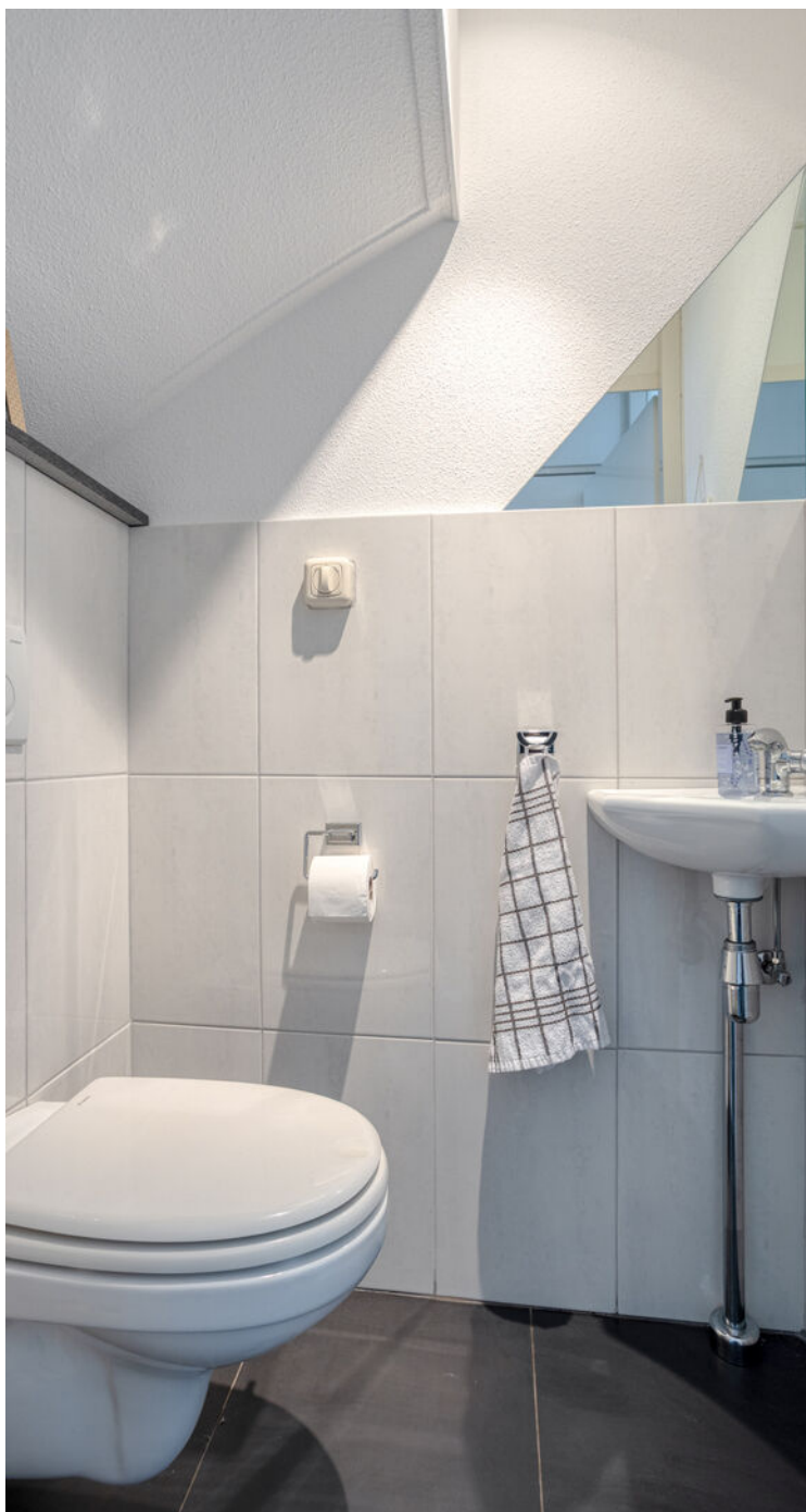
De toiletruimte is voorzien van een zwevend toilet en een fonteintje.
