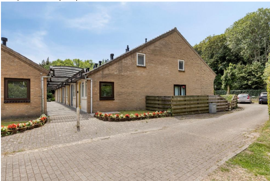
Toegang via een gemeenschappelijk overdekt pad tot de woning aan de rechter zijde.
