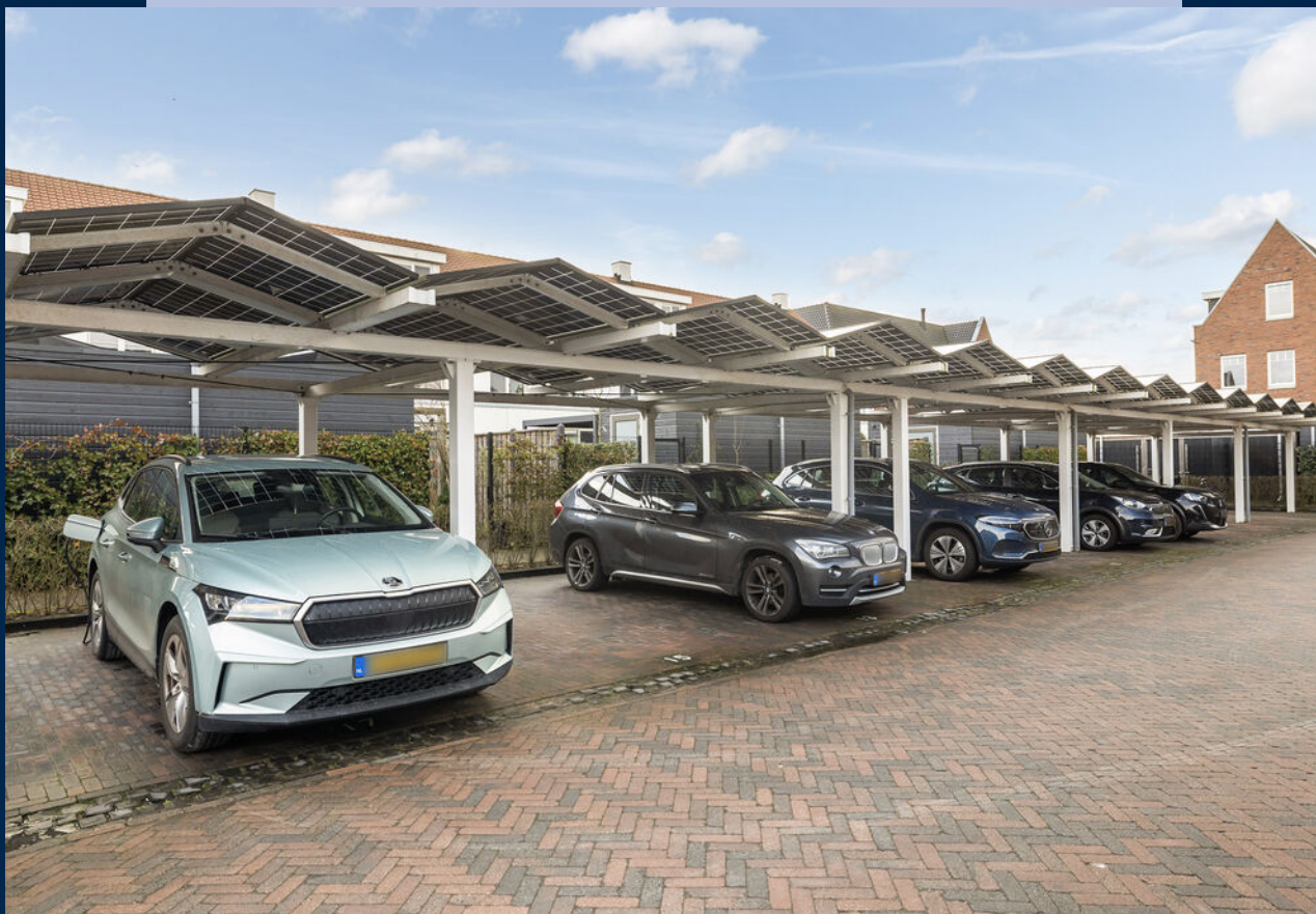
Direct achter de woning bevindt zich de parkeerplaats met carport.
