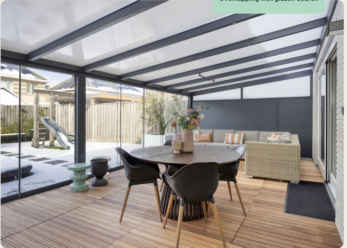
Overkapping met glazen deuren
