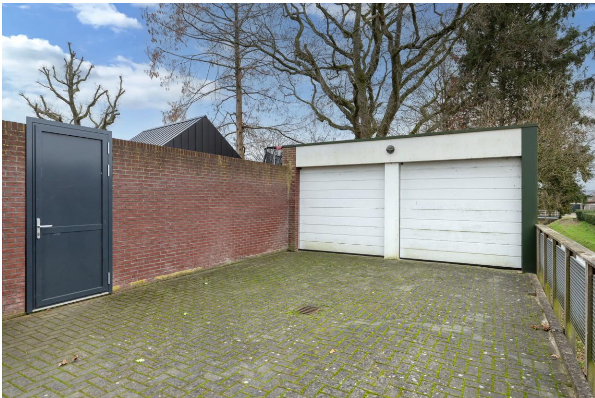
Impressie van de ruime garagebox voorzien van elektrisch bedienbare sectionaaldeur.
