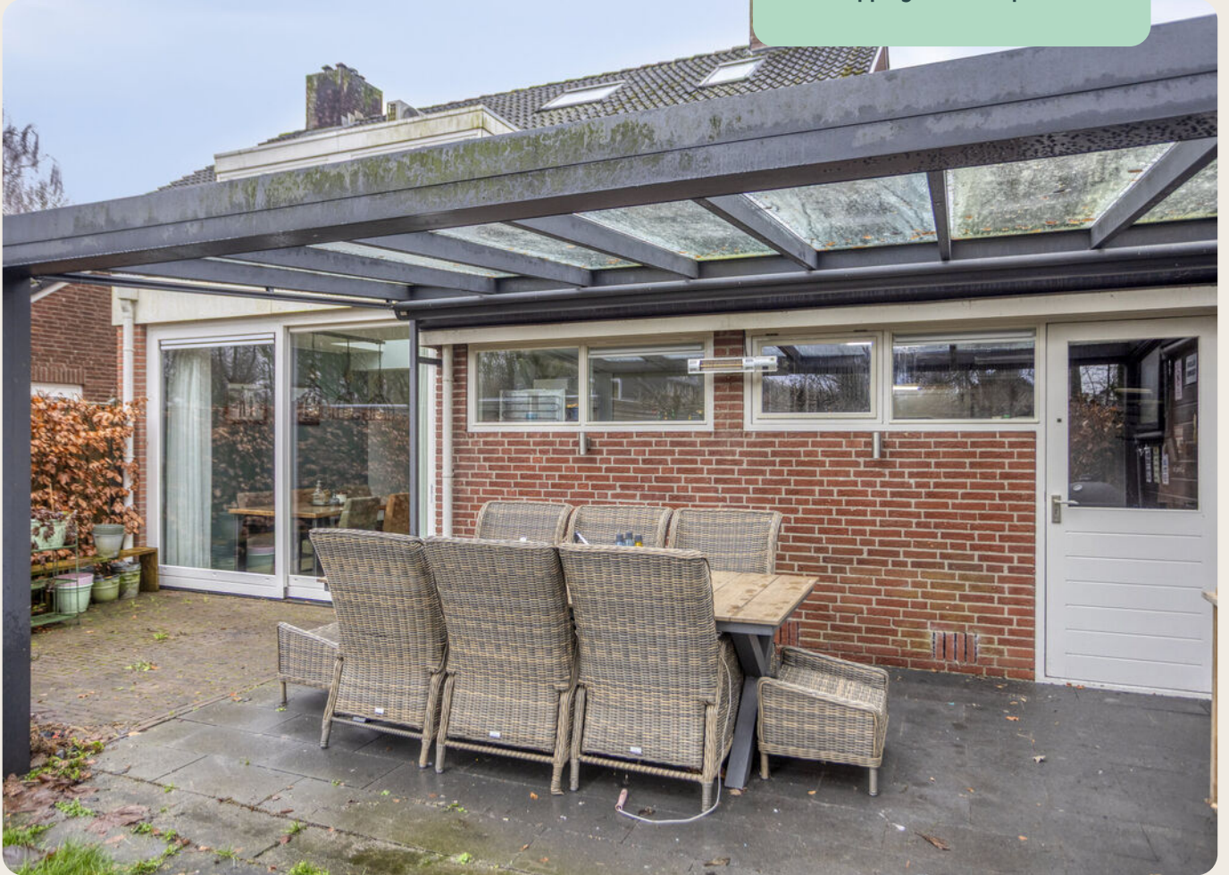
Overkapping met transparant dak
