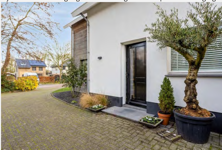
Toegang tot de woning.
