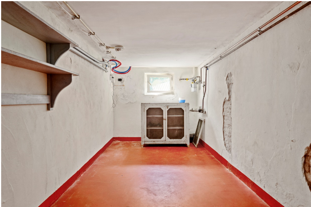
Kelder onder woning
