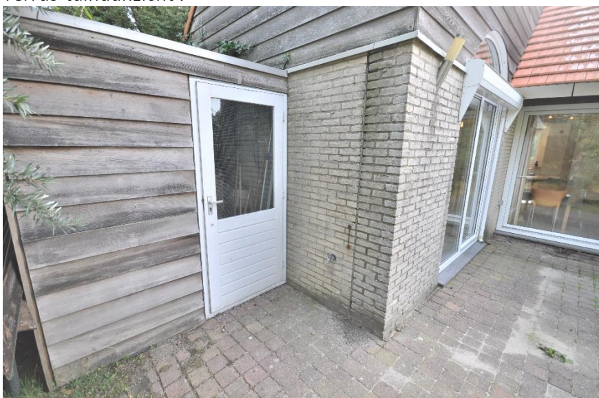
Met aangebouwde houten berging (buitenwerks ca. 2m x 3m) met buitenkraan.
