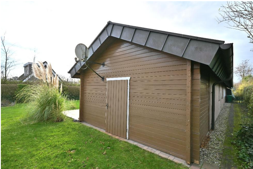
De aangebouwde houten berging.
