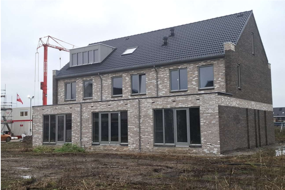
Achterzijde met uitbouw en brede dakkapel
