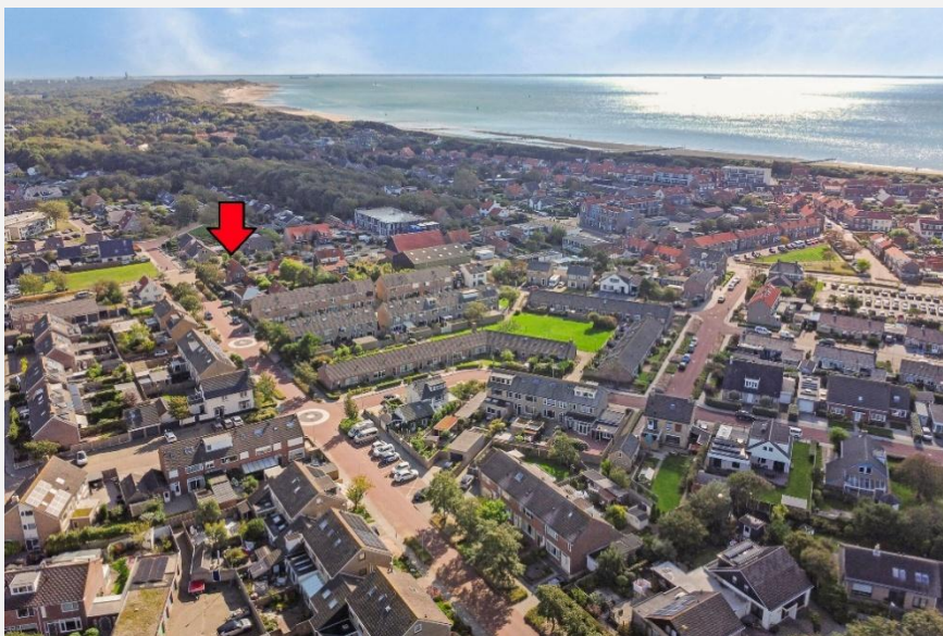
Luchtopname met ligging van de woning met op de achtergrond het strand en de zee.
