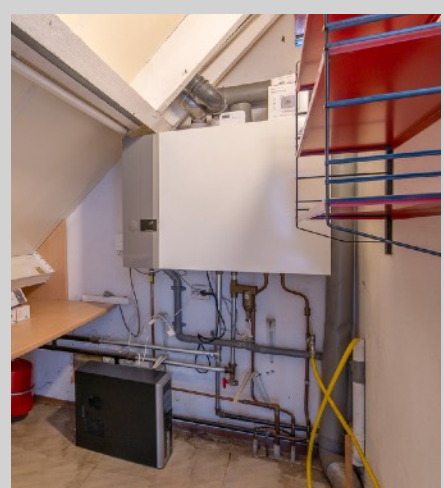
Bergruimte met schuifkastenwand, dakraam en vlizotrap naar de bergzolder. Tweede toilet. Stookruimte met opstelling van de gas cv ketel (Nefit Ecomline HR Excellent, 2005).
