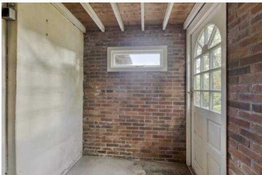
Portaal, aanbouw bij zijgevel
