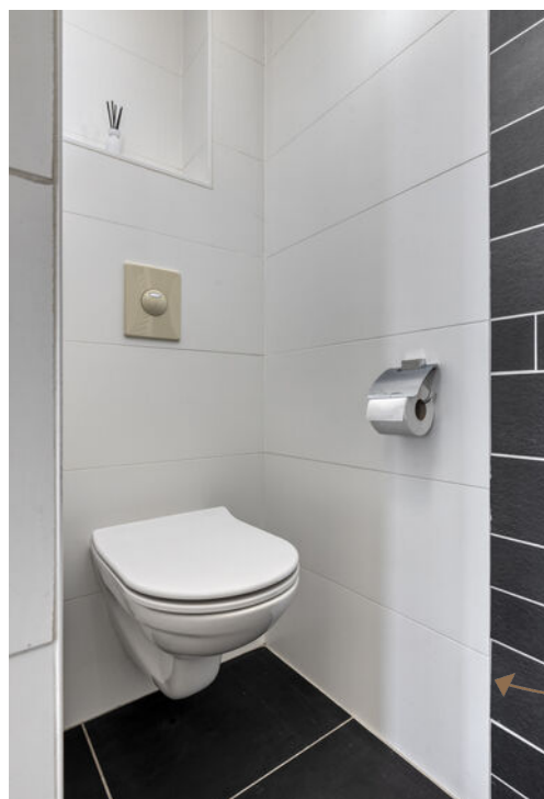
Tweede toilet op de eerste verdieping
