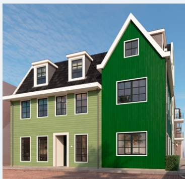
De zijgevel aan de Zeemansstraat, met herkenbare Zaanse details en groene houtlook.
