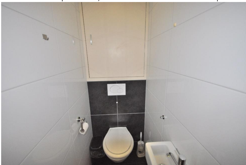
Het toilet met fonteintje en bovendeur met erachter de c.v.-opstelling.
