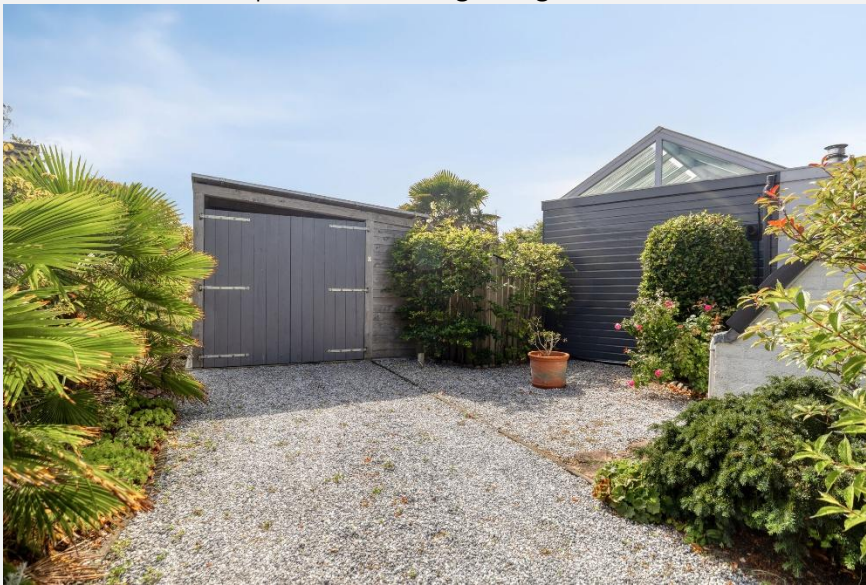
Vanuit de voortuin toegang tot de vrijstaande afsluitbare carport.
