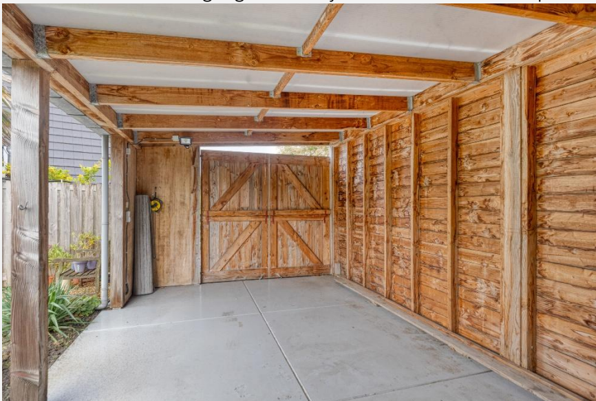
De gedeeltelijk vrijstaande open carport (ca. 27½m²) met de 16 zonnepanelen.
