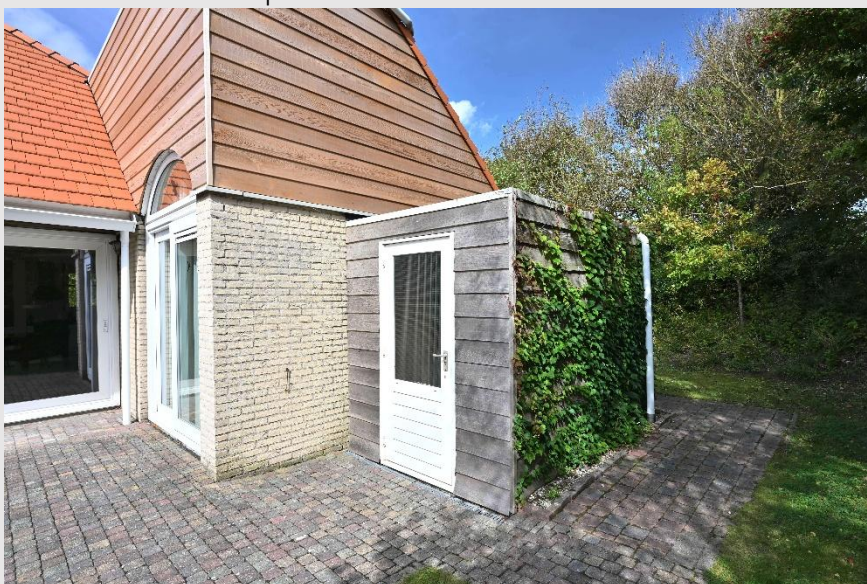
De aangebouwde houten berging (buitenwerks ca. 3m x 2m).
