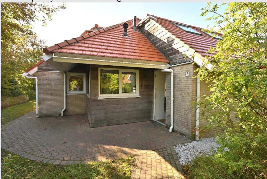
Vooraanzicht en toegang naar de woning.
