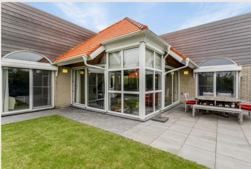
Achteraanzicht met elektrische screen en zonnewering.
