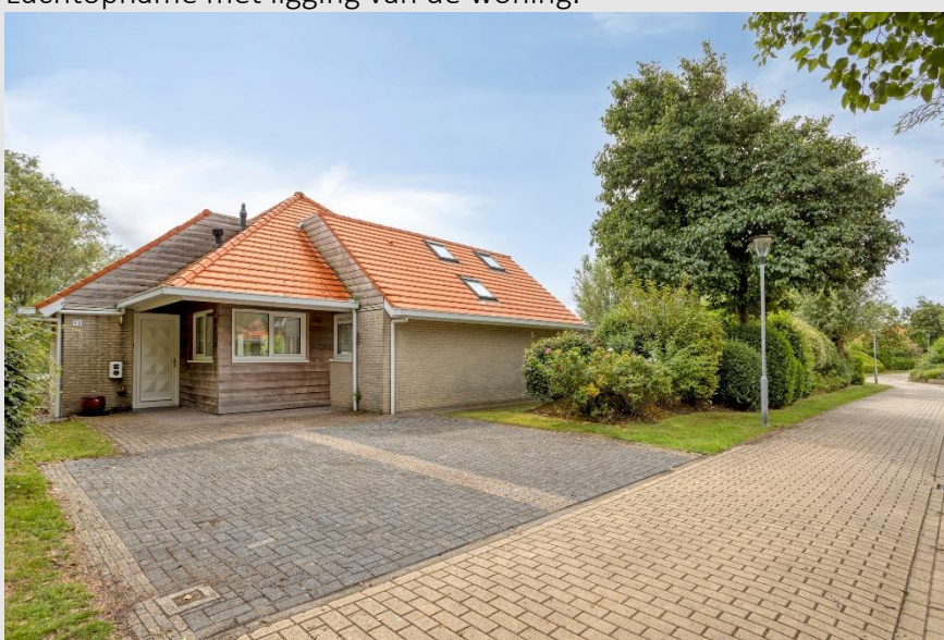
Straatbeeld met links toegang tot de woning.
