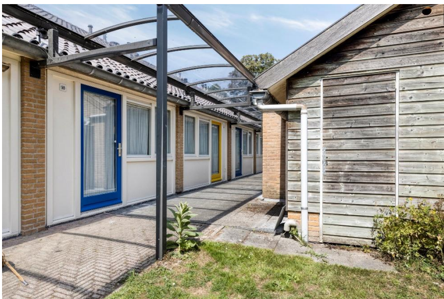
Toegang tot de woning.
