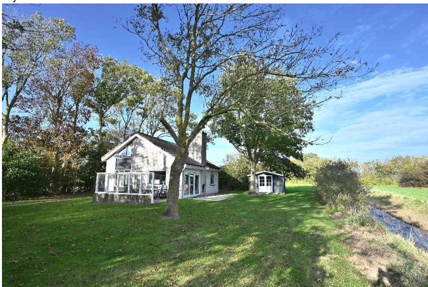
De woning op een mooi perceel gelegen aan de rand van het park.
