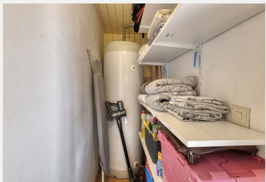
Berging bereikbaar vanuit overloop, met opstelling boilervat.
