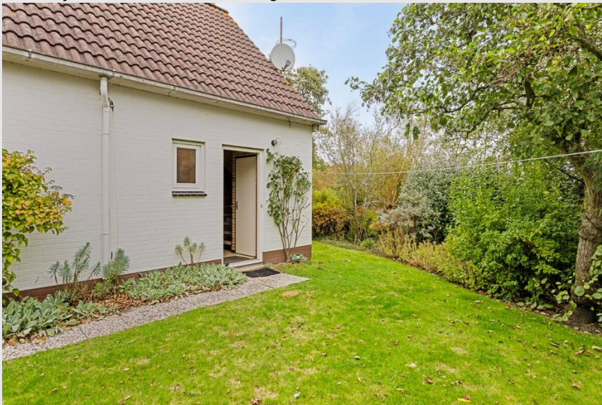
Toegang tot de woning.
