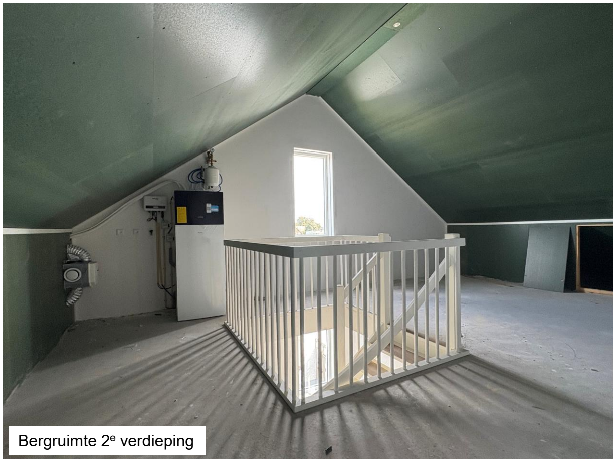
Bergruimte 2 e verdieping
