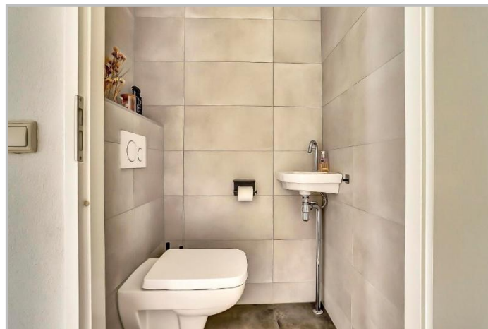
Toiletruimte met zwevend toilet en hoekfonteinje.
