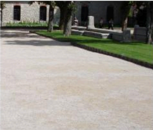
Referentie, oprit van halfverharding
