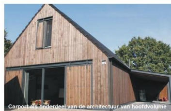
Carport als onderdeel van de architectuur van hoofdvolume
