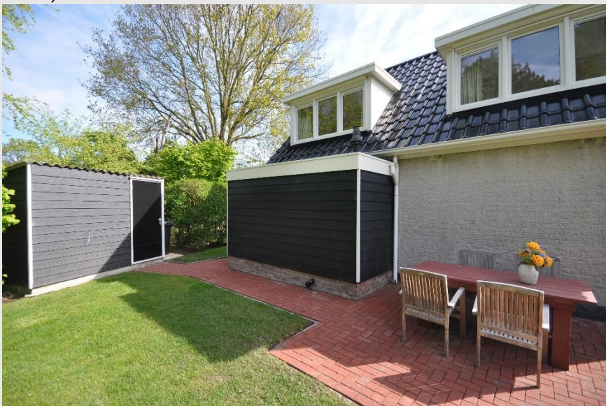
De aangebouwde berging (buitenwerks ca maten 1,55m x 3,90m) met c.v. en wasm.aansl.
