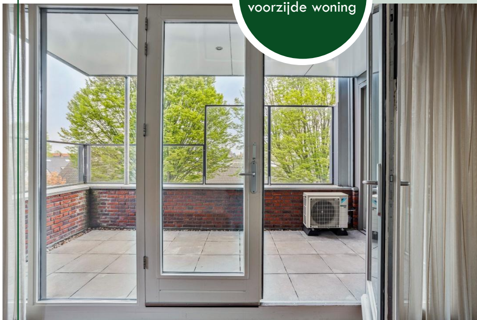
Loggia (2) aan voorzijde woning
