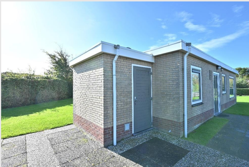
De berging (buitenwerks ± 2,50 m x 2 m) met c.v.-opstelling en wasmachine.
