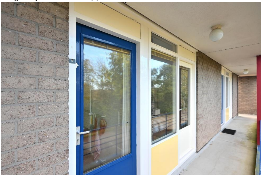
Toegang tot het appartement.
