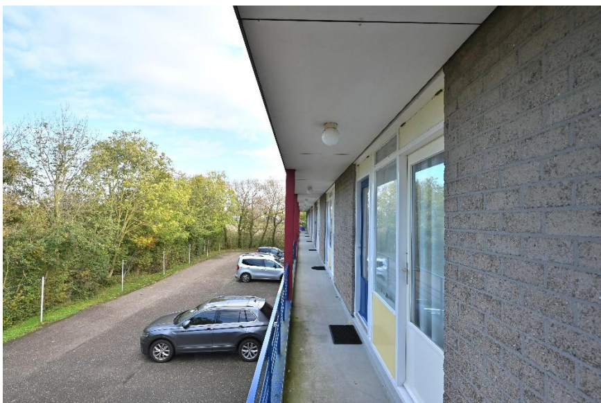
De galerij het tweede appartement rechts.
