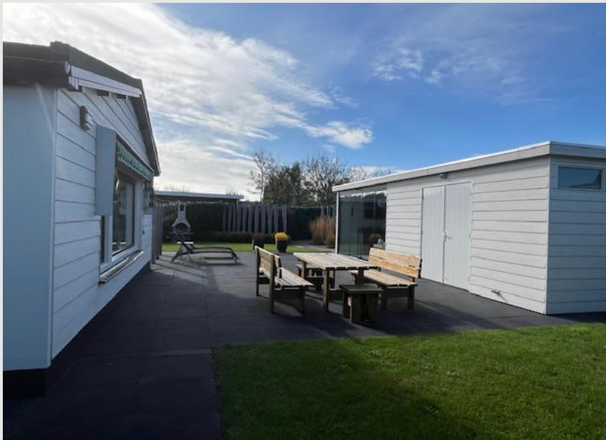
De overkapping met berging (ca. binnenwerks 4,85m x 2,8m).
