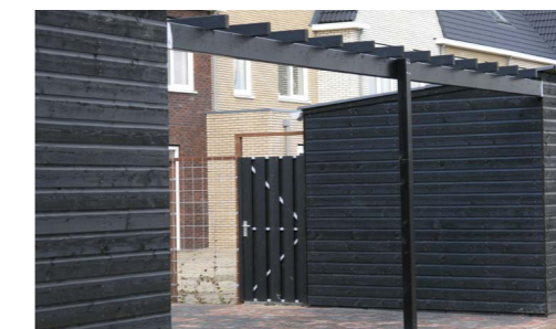
Een pergola constructie verbindt de bergingen met de parkeerplekken en creëert een carport. Deze con tie laat ruimte voor beplanting en heeft een eenduidige beeldtaal.
