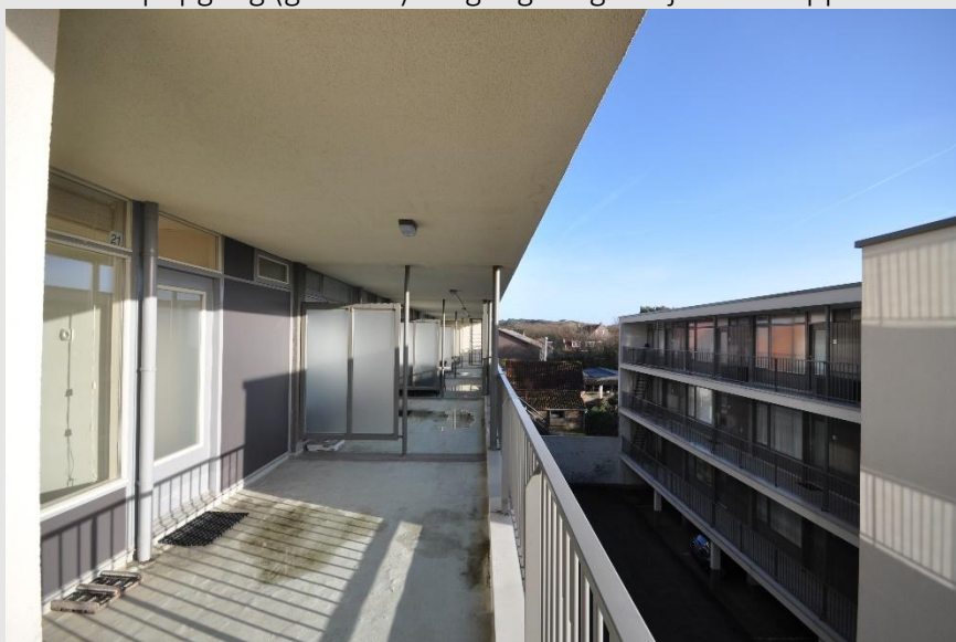
Aanzicht galerij, toegang tot het appartement, nummer 27 , de 4e links.
