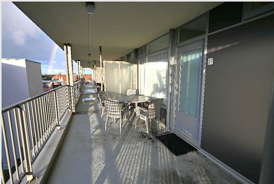
Aanzicht balkon 1 (zuidzijde).
