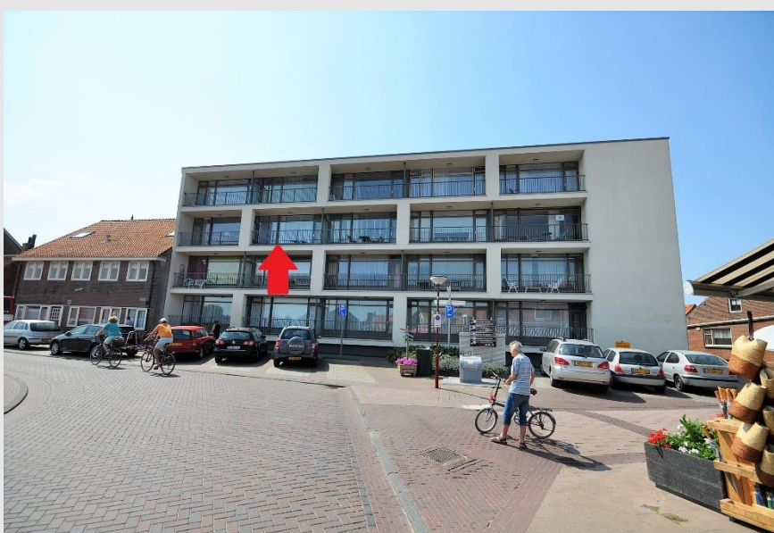
Aanzicht (straatzijde) appartement.
