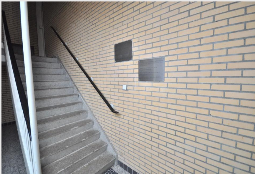
Via de trapopgang (geen lift) toegang via galerij tot het appartement (2 e verdieping).
