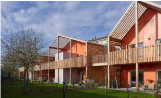
Een pergolastructuur als overgang tussen privéruimte in het huis en openbare ruimte voor het huis. Fungeert eveneens als middel om architectonische eenheid te creëren.
